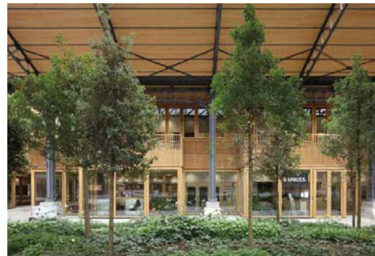
Erschließung auch eine statische Funktion. Sie dienen der Aussteifung und tragen die horizontalen Lasten ab. Das Holzvolumen in Zahlen: 3030m³ BSH, 6020m³ BSP sowie 135m³ Fichten-Furnierschichtholz. Die österreichische Hasslacher Gruppe lieferte dafür die montagefertigen BSH-Holzbauteile direkt auf die Baustelle nach Brüssel. „In unserem Werk in Aichach wurde das gesamte BSP sowie zirka 100m³ Furnierschichtholz produziert“, weiß Züblin Timber-Projektleiter Schimpf. ▶
