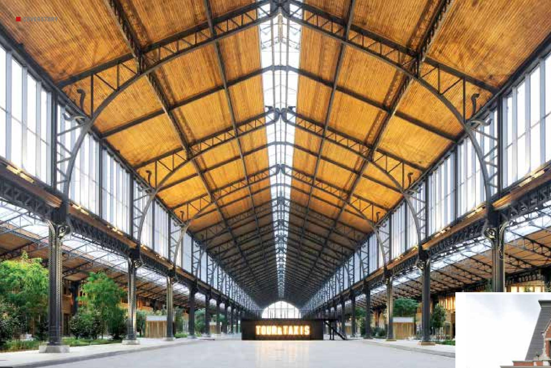
Das riesige Gebäude besteht aus drei größeren und vier kleineren Hallen. Unter den bestehenden Dächern der Seitenschiffe wurden zwölf neue Baukörper hinzugefügt.
