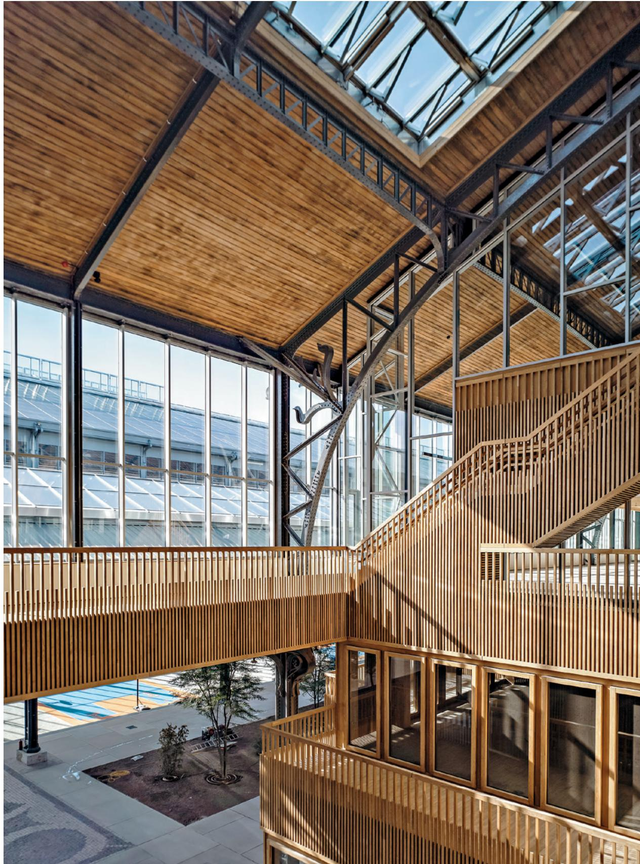
Zur Halle hin schließt eine wärmegedämmte Stahlfassade die offenen Büroplattformen ab. Gegen die Westsonne schützt eine farbneutrale elektrochrome Verdunkelung.
