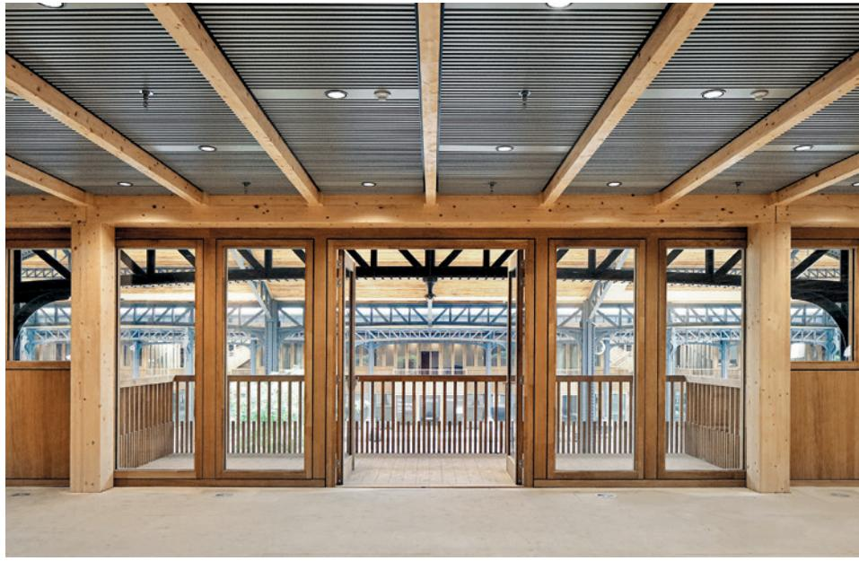
Im Inneren der Pavillons kehrt die geriffelte Fassadenstruktur an den angehängten Holz- und Kühldecken wieder. Darin sind auch Leuchten, Brandmelder und Sprinkler integriert.
